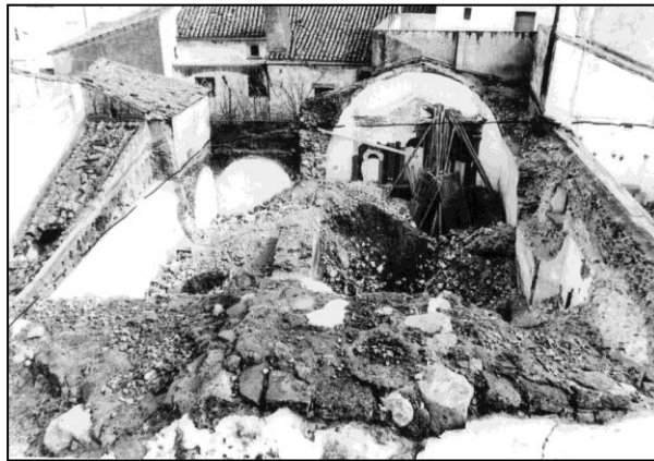
Demolición de la sinagoga-ermita de Santa Catalina en 1977. © MNARM.
